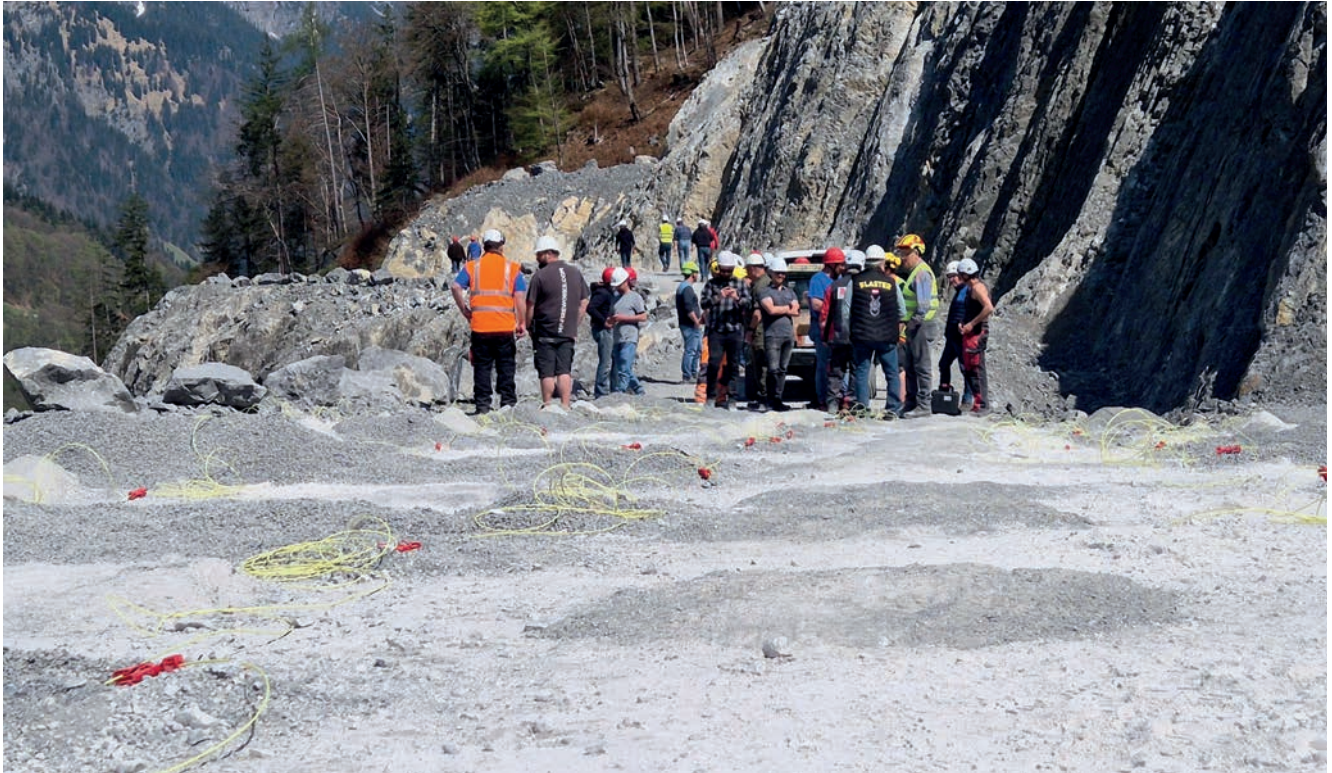
Vorbereitete Sprenganlage im Steinbruch Lorüns: Bohrlöcher, Zündleitungen und Sicherungsabläufe wurden vor Ort anschaulich erklärt.
