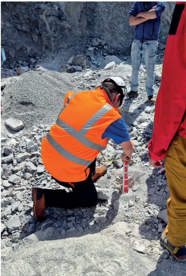
Unter fachlicher Anleitung konnten die Teilnehmer einzelne Arbeitsschritte bei der Vorbereitung der Flächensprengung mitverfolgen und begleiten.
